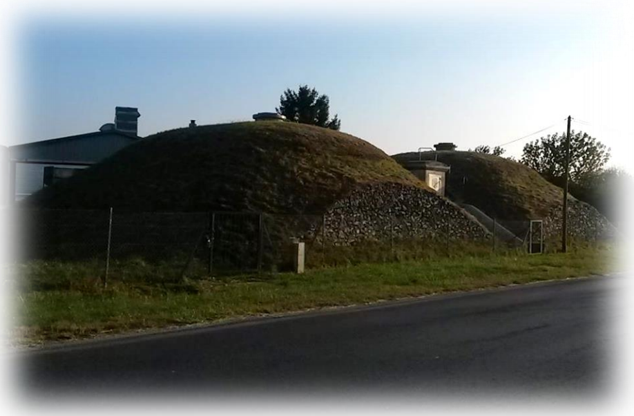
© SAGE des Deux Morin – Captage d'alimentation en eau potable – Esternay
