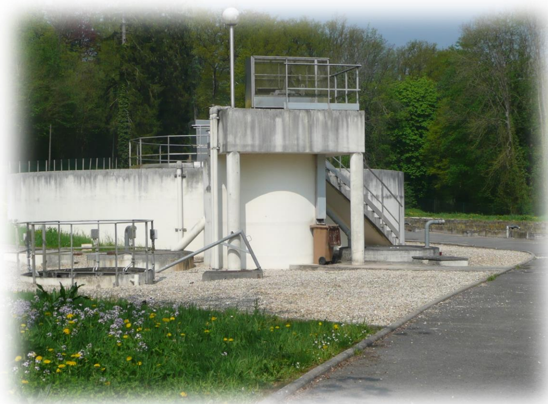
© SAGE des Deux Morin – Station d'épuration – Jouy-sur-Morin
